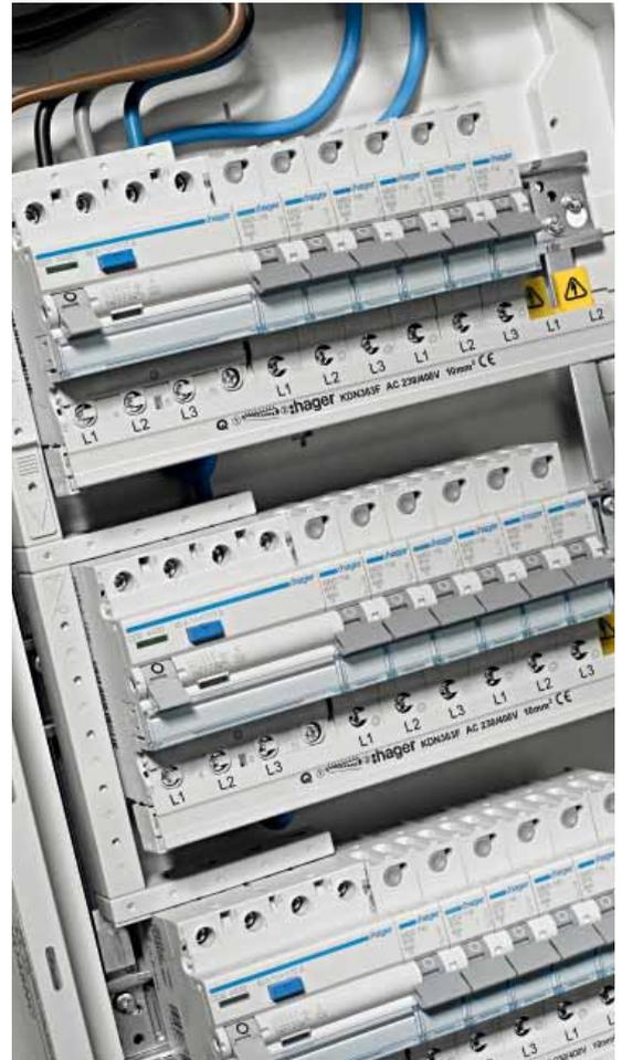
Mit dem senkrechten Verteilereinbau lassen sich in Kombination mit den horizontalen Phasenschielen LS- und FI-Schalter schneller als je zuvor in alle volta Installationskleinverteiler und in univers Z-Schränke einbauen. Die aufwändige und zeitraubende Handverdrahtung von einer Reihe zur darüber- oder darunterliegenden wird damit überflüssig.
